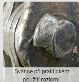
Provizorní navařování nýtovaných čepů.
